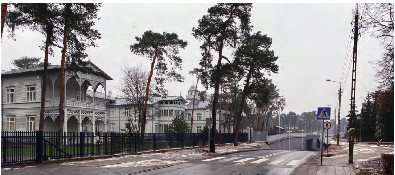
Tunel przy zabytkowym Pensjonacie Gurewicza w Otwocku. Pas drogowy wraz z chodnikiem ma niecałe 15 m.
