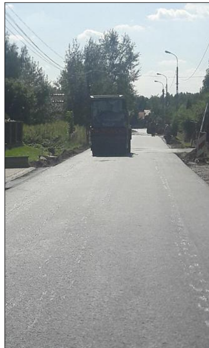
Ul. Diamentowa w Pogorzeli - asfaltowa
