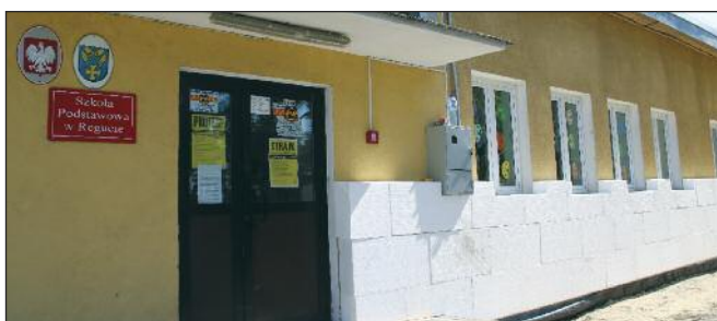
Ocieplenie ścian budynku szkoły w Regucie
