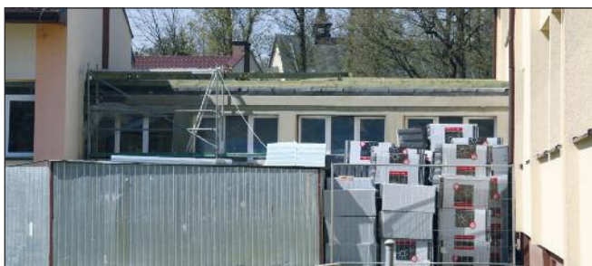
Remont dachu na łączniku szkoły w Celestynowie
