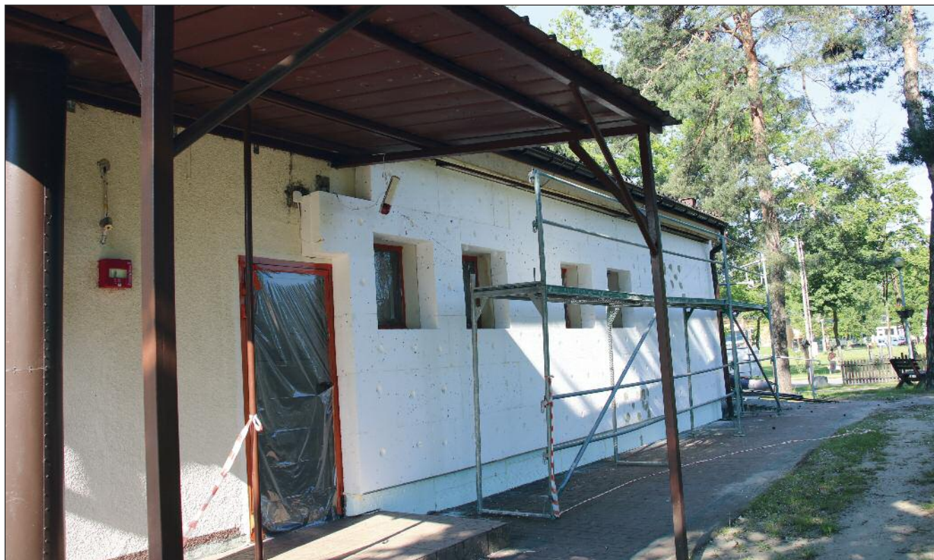
Na ukończeniu są prace termomodernizacyjne na budynku GOKiS-u
