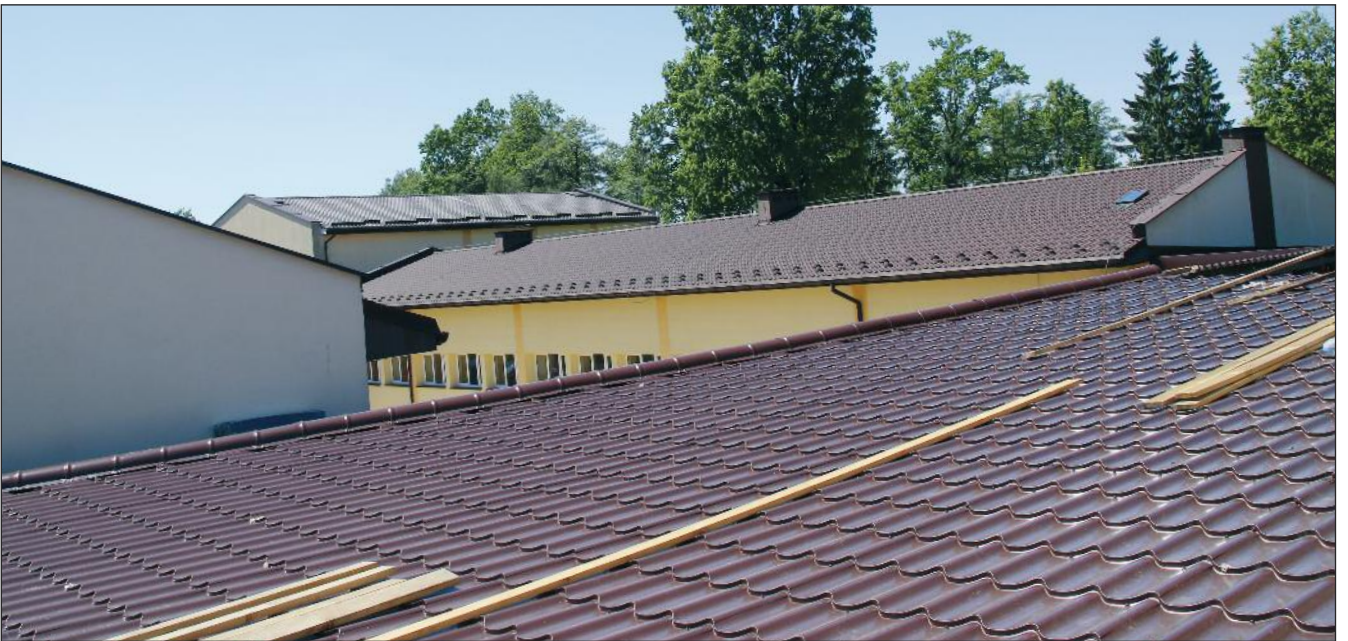
Dach na łączniku SP przy ul. Św. Kazimierza pokryty jest już blachą. Trwają prace wykończeniowe
