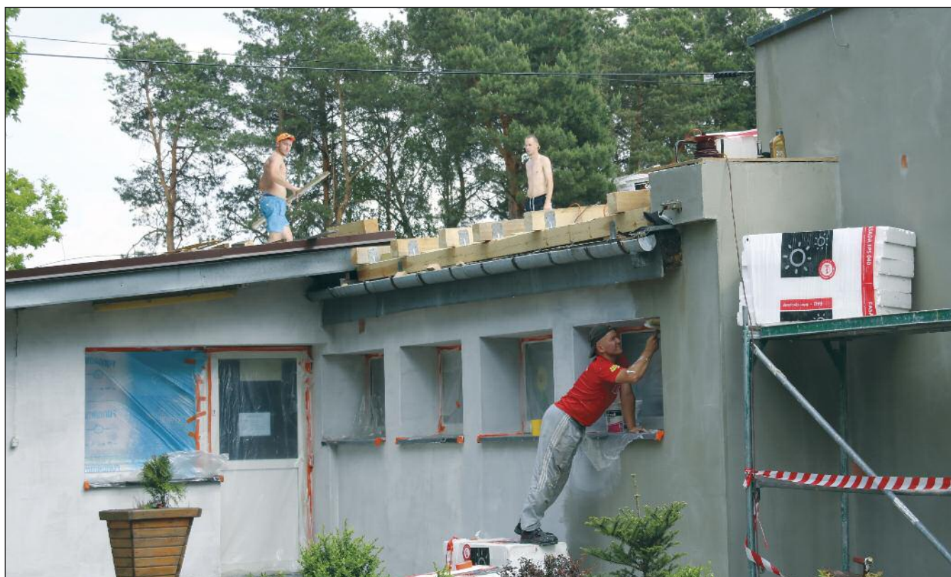
Budynek szkoły w Regucie jest już w 80% docieplony. Aktualnie wymieniane jest pokrycie dachowe
