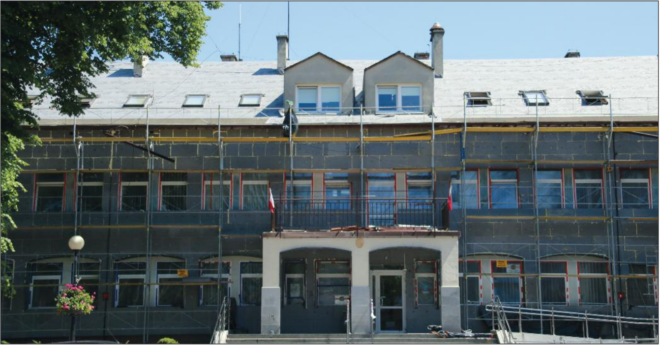
Budynek urzędu Gminy jest już w dużej części docieplony, trwają też prace wymiany pokrycia dachowego
