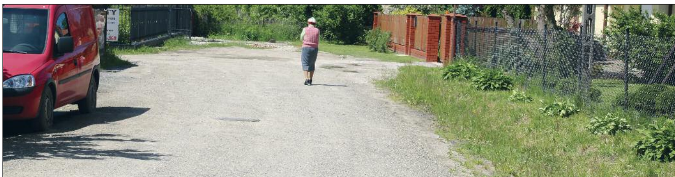
Ślepa uliczka odchodząca od ul. Prusa w Celestynowie. Naprzeciwko niej będzie remontowana też druga, również ślepa
