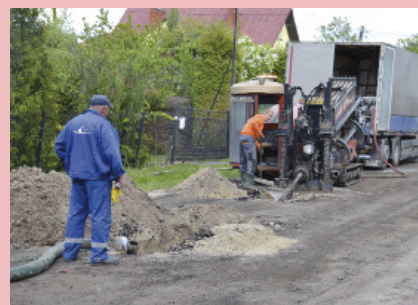
Bydowa kanalizacji na ul. Laskowskiej w Celestynowie Red.
